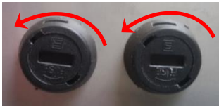
Figuur 22: Vervanging van de zekeringen
