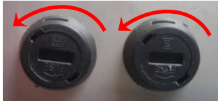
Figura 22: Sostituzione dei fusibili
