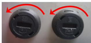
Figure 22: Remplacement des fusibles
