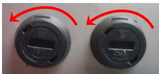
Figura 22: Sustitución de los fusibles
